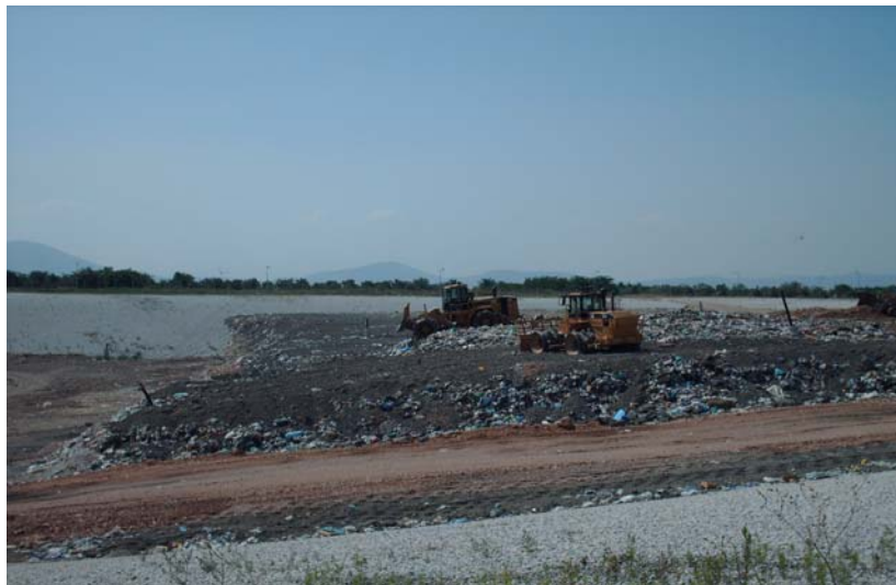
Εικ. 6.2: Μέτωπο απόθεσης απορριμμάτων στο ΧΥΤΑ Δυτικής Μακεδονίας (φωτ. Κ. Βουδούρης).
