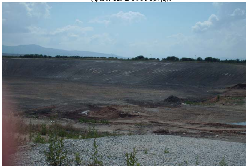
Εικ. 6.3: Δημιουργία νέου κυττάρου στο ΧΥΤΑ Δ/κής Μακεδονίας (φωτ. Κ. Βουδούρης).
