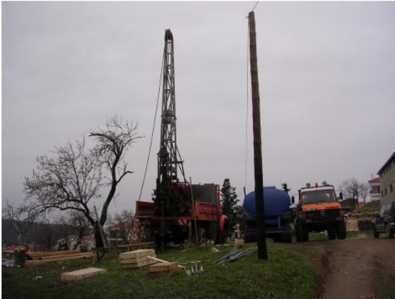
Γεωτρητικός Εξοπλισμός στη Θέση της Ερευνητικής Γεώτρησης ΑΣΠ-8
