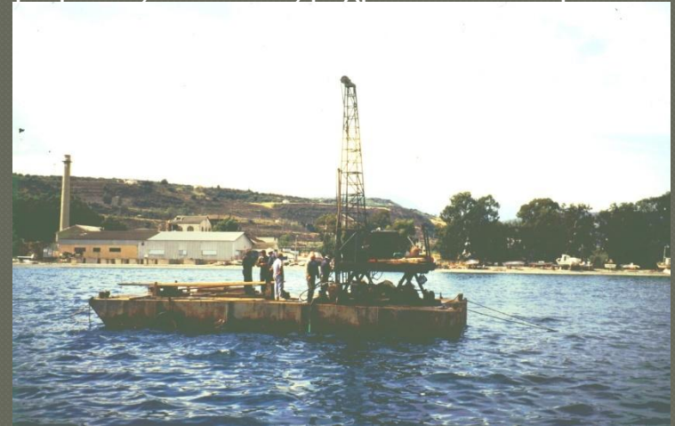
(δ) γεωτρύπανο επί πλοίου για γεωτρήσεις ανοικτής θάλασσας
