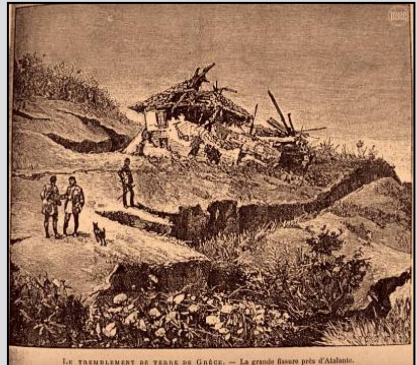
Εδαφικές ρωγμές κοντά στην Αταλάντη μετά το σεισμό της 27ης Απριλίου 1894 ( M=7.0 ) (Earthquake Engineering Research Center).
