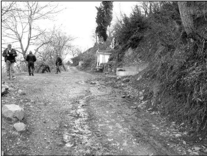
Σχήμα 2. Μικροπηγή εντός του χώρου του οικισμού των Καναλιών. Διακρίνεται η ανεξέλεγκτη ροή των νερών που εμποτίζουν συνεχώς τα εδαφικά υλικά.
